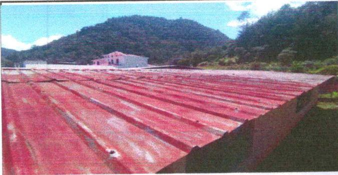
Foto 1: lámina en malas condiciones
