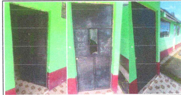
Foto 6: Mantenimiento de puertas
