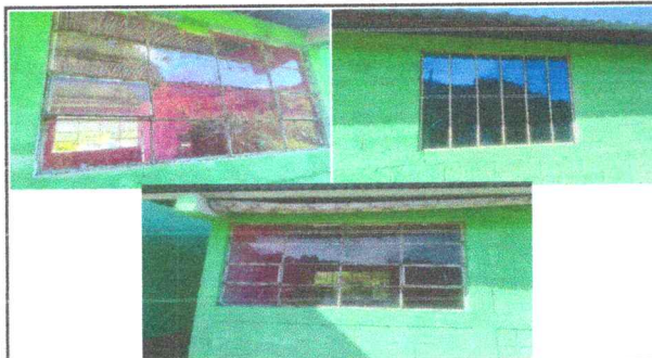
Foto 3: Mejoramiento de balcones para ventanas
