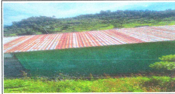
Foto 4: Cambio de Lamina en cocina
