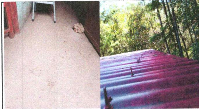
Foto 3: Piso de torta en malas condiciones en la cocina y laminas en estado oxidadas con algunas goteras.
