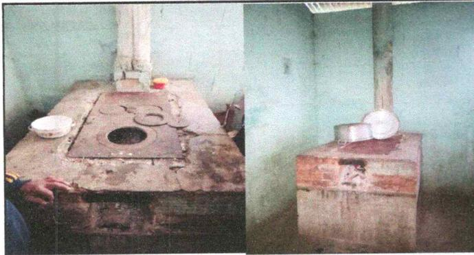
Foto 1: Plancha y chimenea en malas condiciones y en deterioro
