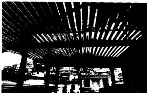
Sustitución de lámina por lámina troquelada. Galera depósito de agua.
