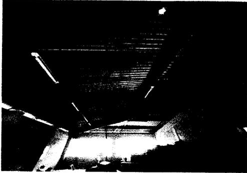
Sustitución de lámina por lámina troquelada calibre 26. Dirección
