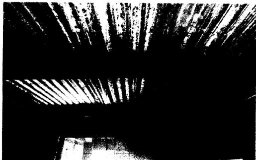
Sustitución de estructura de madera por metal. Bodega
