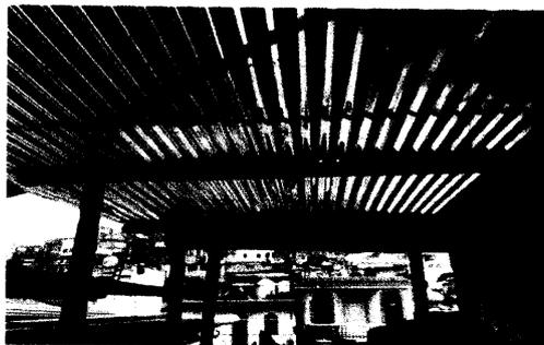
Sustitución de estructura de madera por metal. Galera depósito de agua Sustituir
