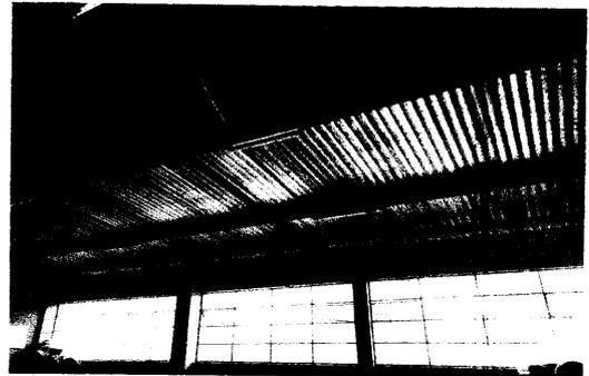
Sustitución de lámina por lámina troquelada calibre 26. Aula 1
