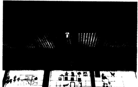
Sustitución de lámina por lámina troquelada calibre 26. Aula 3
