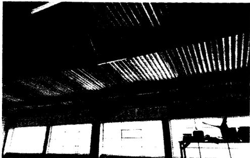
Sustitución de lámina por lámina troquelada calibre 26. Aula 2
