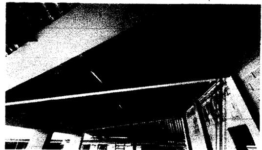
Sustitución de lámina por lámina troquelada calibre 26. Pasillo 2, bodega y galera
