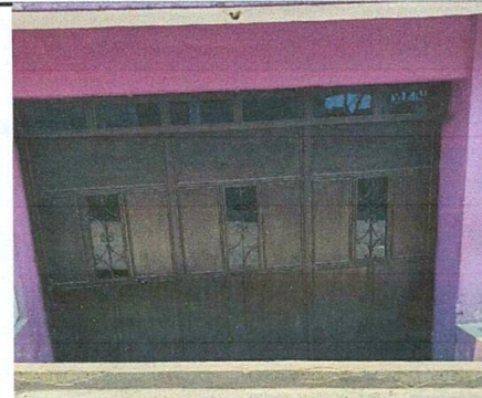
Foto 6: Sustitución de portón finalizada.
