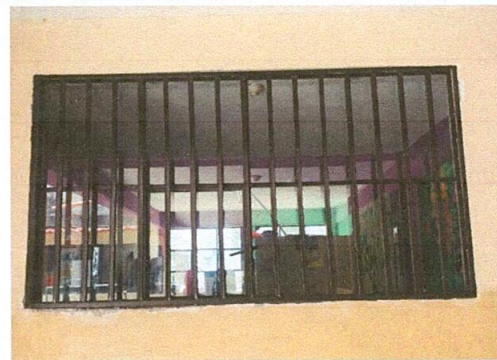
Foto 4: Sustitución de balcones y ventanas finalizada
