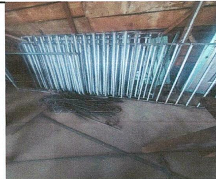
Foto 6: Elaboración de balcones
