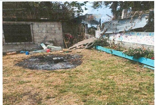
Foto 4: Inicio de los trabajos por parte de padres de familia.
