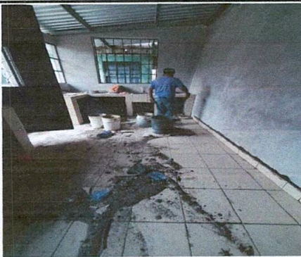
Foto 5: Sustitución de piso
