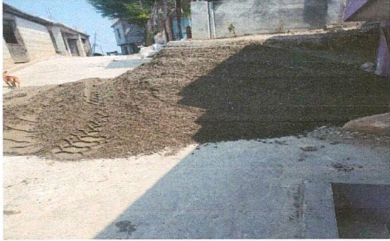
Foto 1: Entrega de material de construcción.
