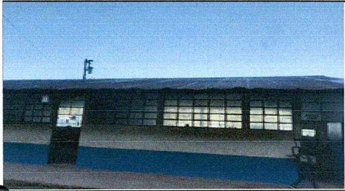
Foto 1: Sustitucion de lamina por lamina
