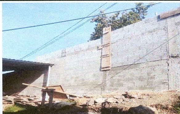
Foto 3. Finalización y/o reparación de muro perimetral de block, soleras intermedias y columnas.
