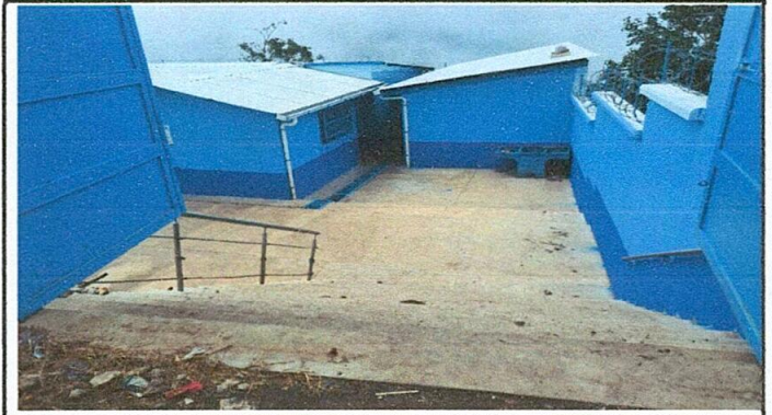
Foto 2: Pintada de muros finalizadas
