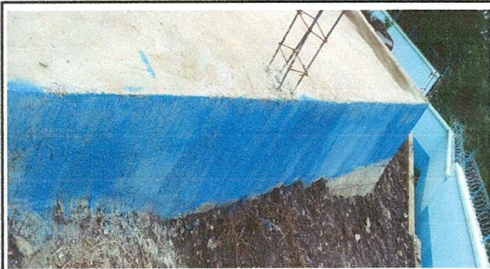
Foto 3: Muro de contención finalizada
