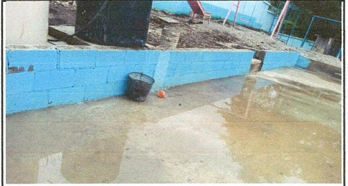
Foto 4: Muro de contención finalizada
