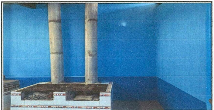
Foto 6: Instalación de chimenea finalizada
