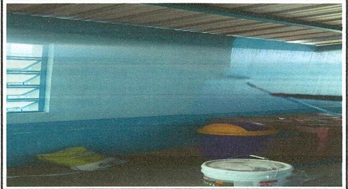
Foto. 2 Pintada de muros interiores
