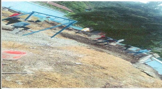
Foto 1: Trabajos realizados en losa de pao
