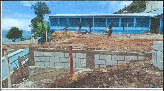
Foto 4. Trabajos realizados en sustitucion de muros
