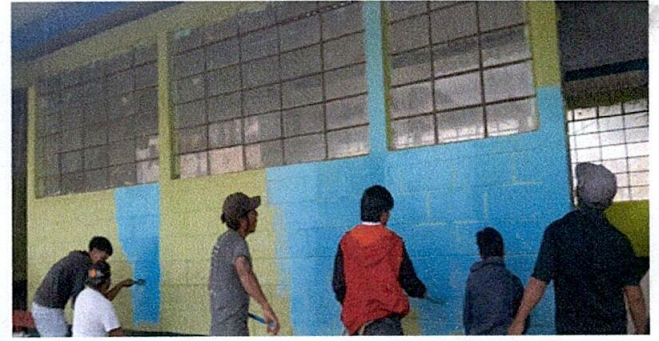
Foto 8 Pintura de muros exteriores e interiores
