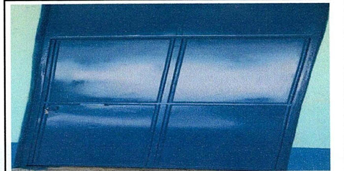
Foto 4: Mantenimiento de puertas
