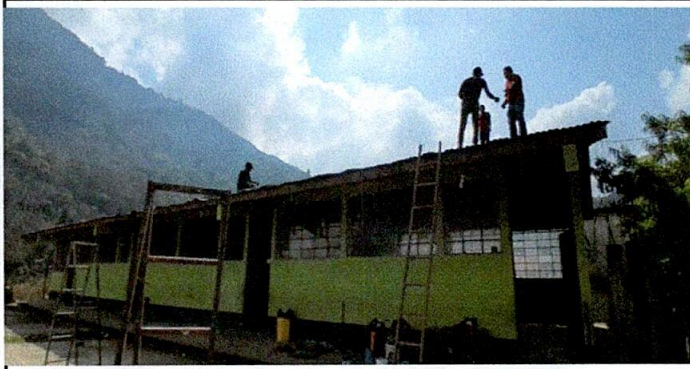
Foto 1: Sustitucion de lamina por lamina
