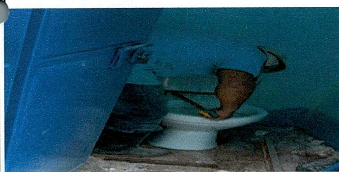
Foto 5 : Sustitución de inodoros
