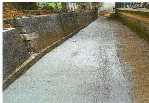
Foto 4: Reparación de cuneta de concreto finalizada
