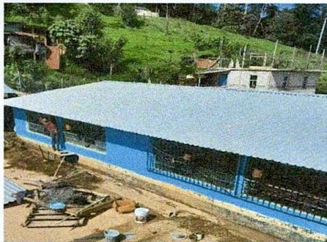
Foto 1: Sustitución de lámina finalizada
