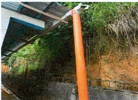
Foto 3: Sustitución de canal de pvc finalizada
