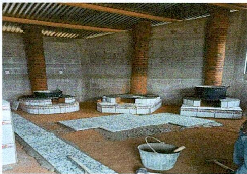
Foto 5: Sustitución de piso
