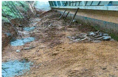
Foto 6: Inicio de trabajo de cuneta
