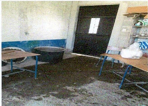
Foto 3: Sustitución de piso por piso granito
