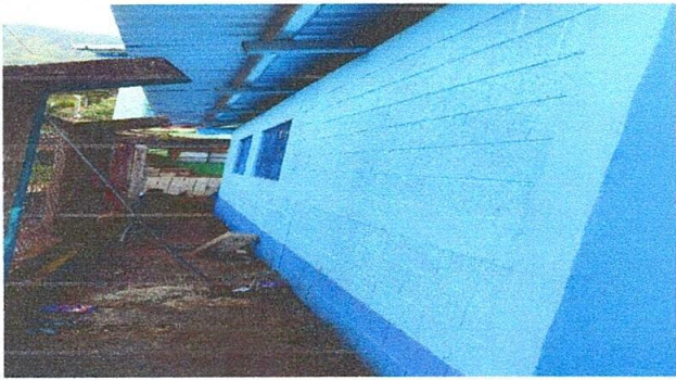
Foto 3: Después (Sustitución de pared)
