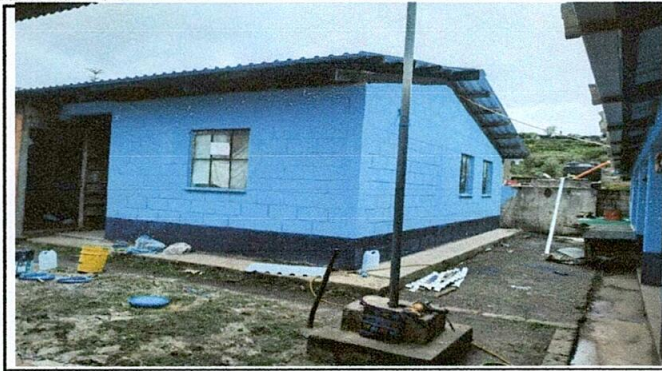
FOTO 1: SUSTITUCIÓN DE LÁMINA
