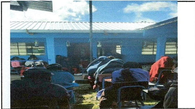
SUSTITUCION DE LÁMINAS DE ZINC POR LAMINAS TROQUELADAAS
