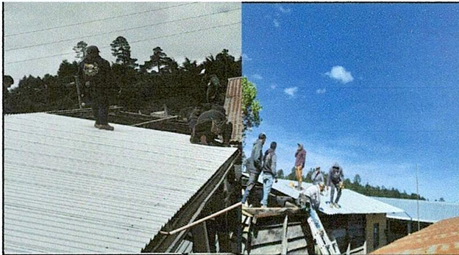
FOTO 1: SUSTITUCIÓN DE LÁMINA
