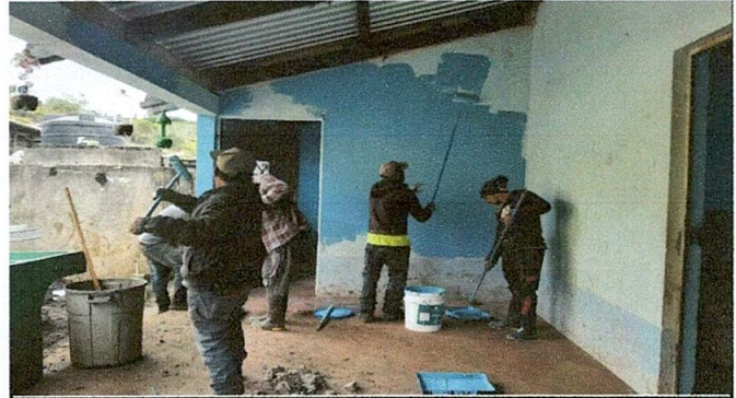
FOTO 4: PINTURA EN MUROS EXTERIORES E INTERIORES
