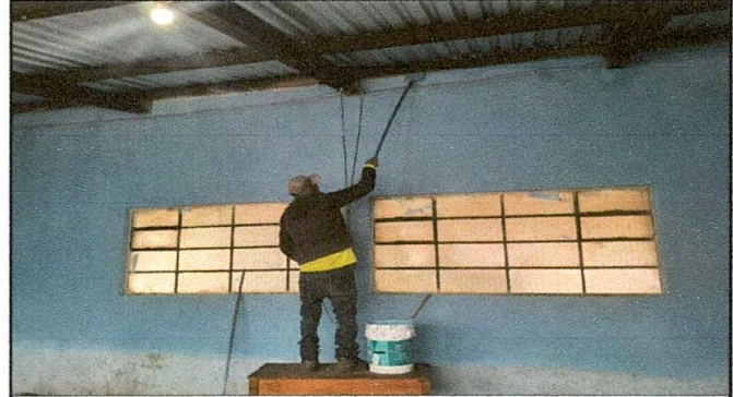
FOTO 4: PINTURA EN MUROS EXTERIORES E INTERIORES
