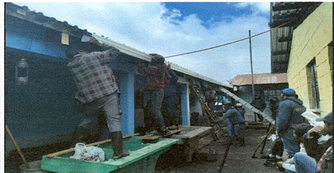
FOTO 5: SUSTITUCIÓN DE CANAL PVC
