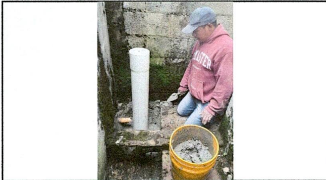
FOTO 3 SUSTITUCION DE TUBERIA LINEAL DE PVC, AGUAS NEGRAS DE 6"
