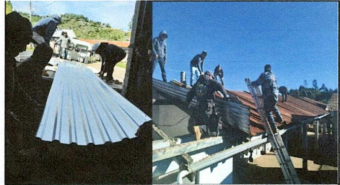
Trabajos de recepcion de material y desetechado
