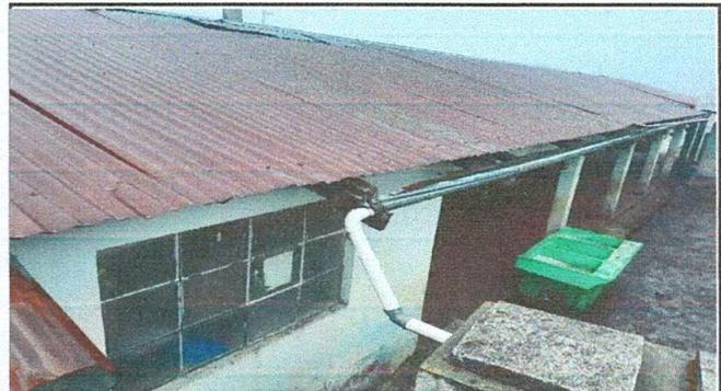
FOTO 2: SUSTITUCIÓN DE BAJADA DE AGUA PLUVIAL
