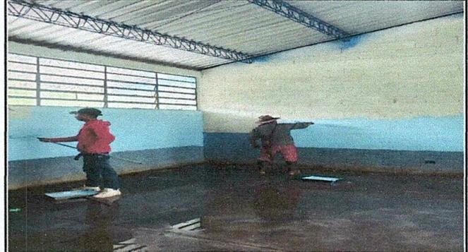
Foto: Aplicación de pinturas en muros.
