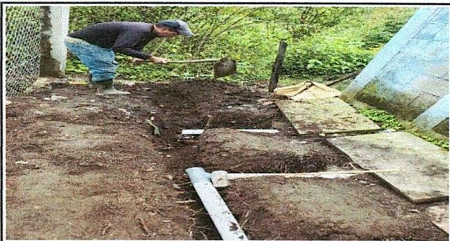
Foto: Sustitución de tubería de red de drenaje
