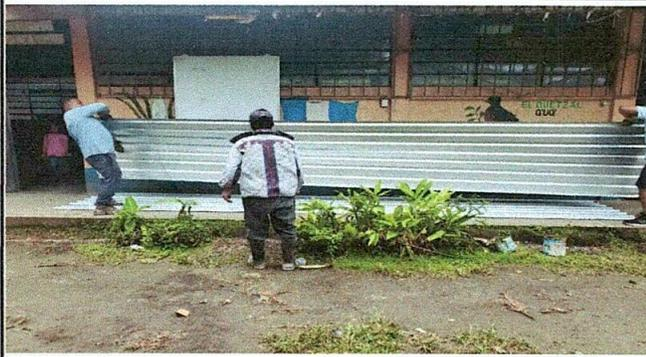
Foto: Instalación de láminas
