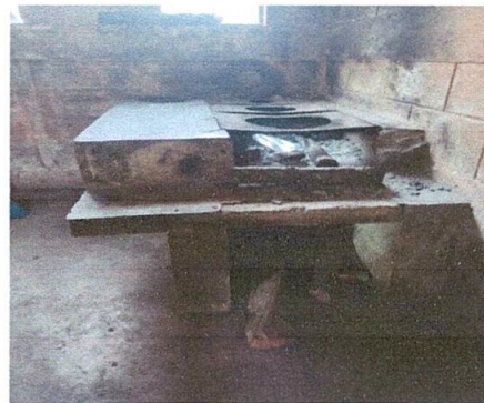
Foto 4: Estufa rural en mal estado
