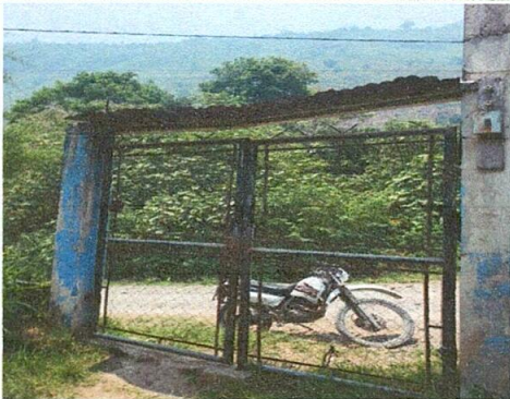
Foto 3: Portón en mal estado
