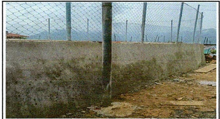
Foto 4. Muro de contención Finalizado
