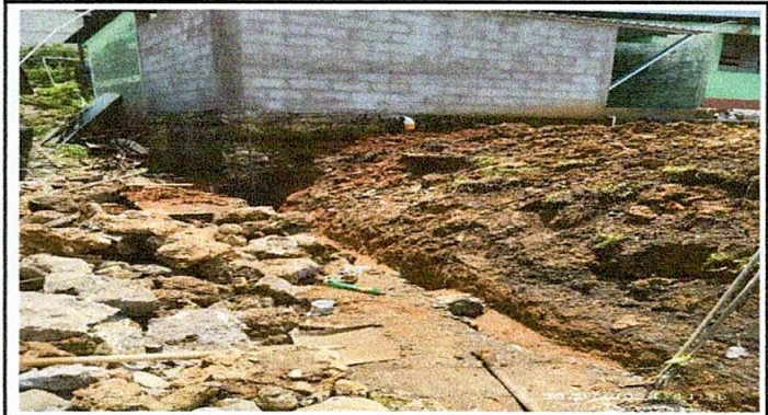
Foto 4. Muro de contención en proceso.
