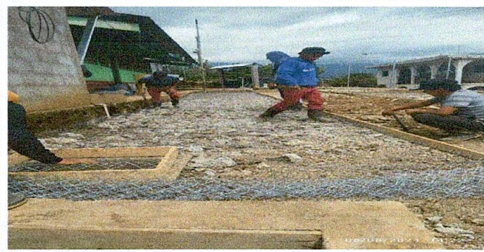
Foto 5. Sustitución de cajas de registro en proceso.
