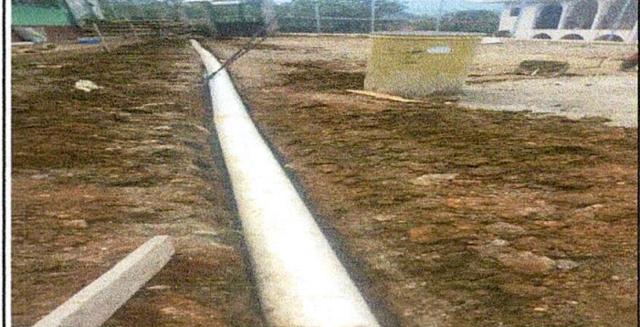
Foto 6: Sustitución de tubería PVC línea principal aguas pluviales.
