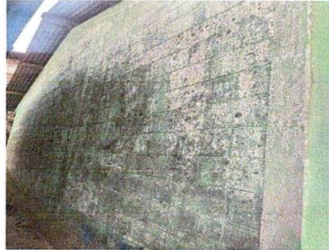
Foto 2: Pintura de paredes en mal estado
