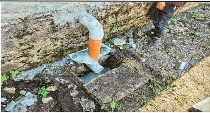
Foto 5: Sustitución de caja de registro en mal estado.
