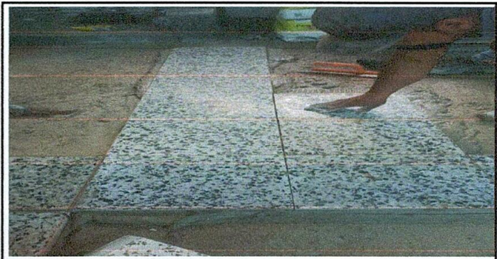
Foto 6: Sustitución de piso por piso de granitos
