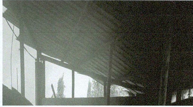
Foto 1. Sustitución de lamina por lamina troquelada
