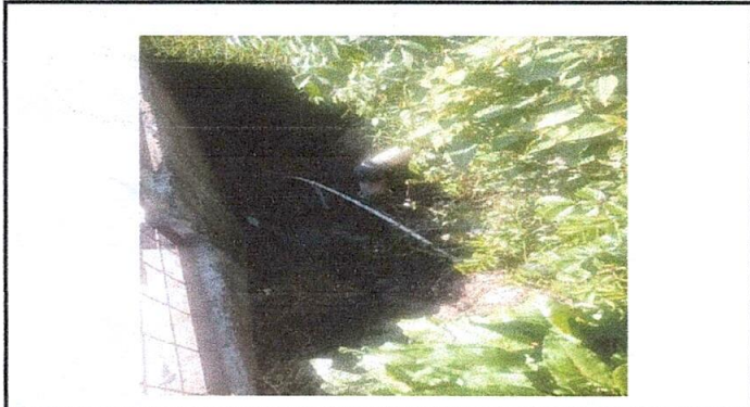
Foto 9: Tubería de drenaje quebrados, en mal estado y mala instalación.
