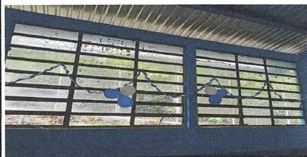
Foto 4: Sustitución de vidrios
