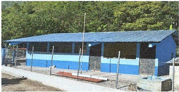
Foto 1: Cambio de techo
