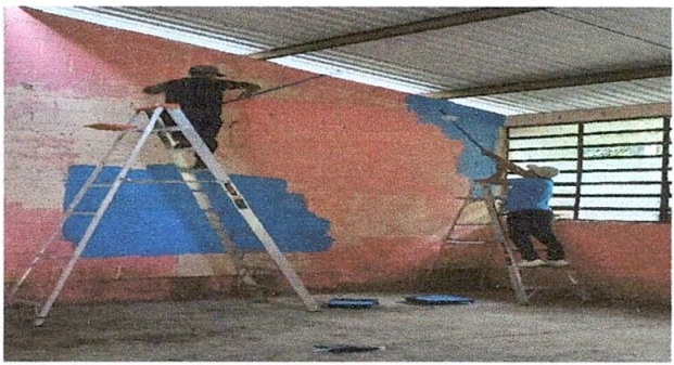
Foto 3: Pintado de paredes
