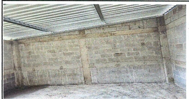
foto 6 aulas con paredes completas
