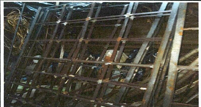
foto 4 ventanas en proceso de arreglar
