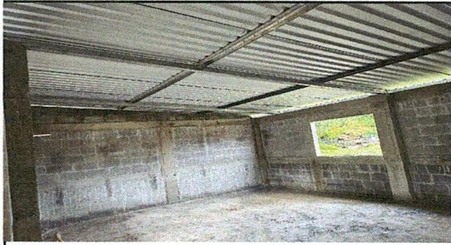
foto 1 cambio de laminas en deterio
