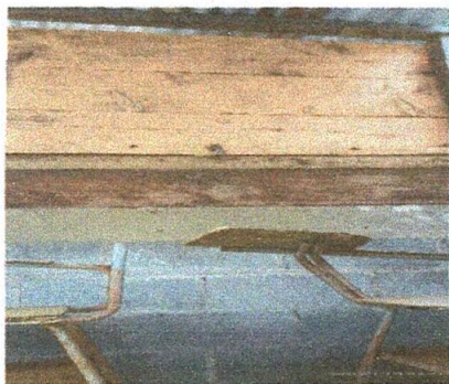
Foto 5: Completación de paredes
