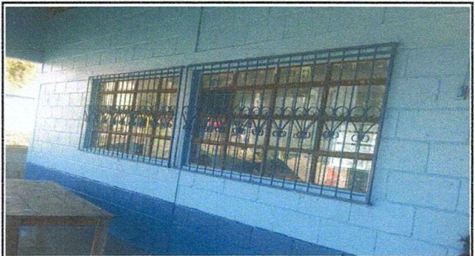
Foto 4: Sustitución de balcones finalizada
