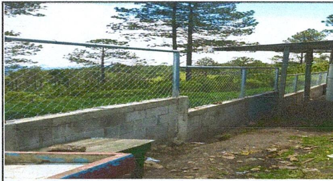
Foto 1: Sustitución de madera por tubos AG finalizada
