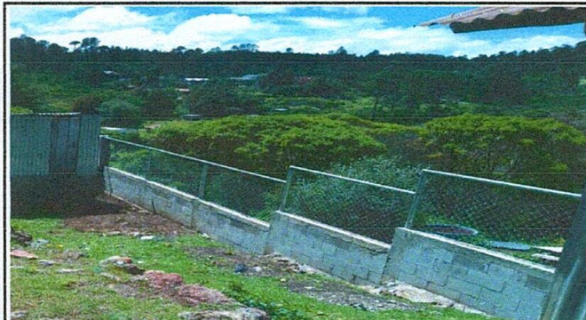
Foto 3: Sustitución de malla por muro perimetral finalizada
