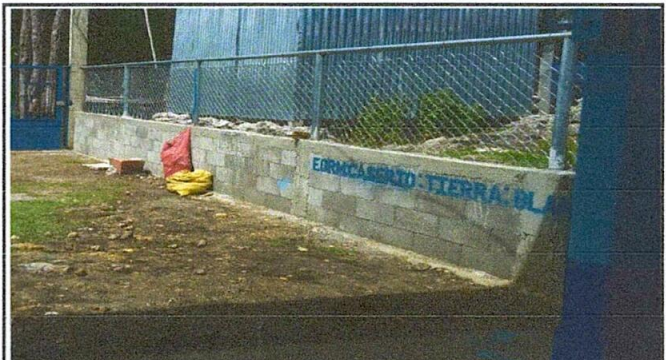
Foto 2: Sustitución de malla finalizada
