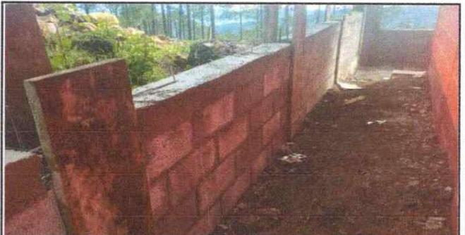
Foto 6: Colocación de blok, vigas y llenado de columnas
