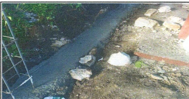
Foto 5: Colocación de columnas
