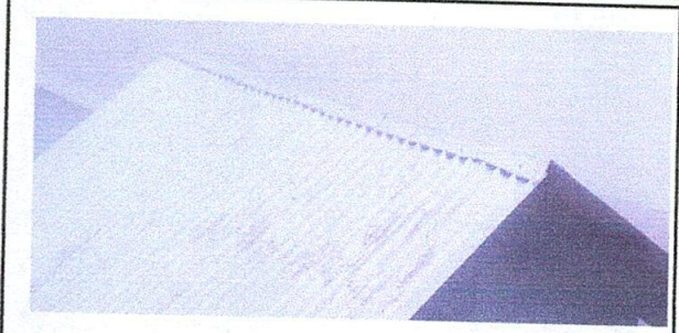
Foto 7: sustitución de capote de lámina para lámina troquelada
