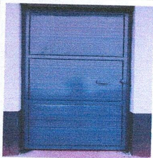
Foto 9: sustitución de puerta
