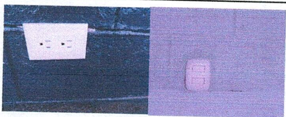
Foto 11: sustitución de interruptores y tomacorrientes
