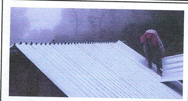
Foto 7: sustitución de capote de lámina para lámina troquelada
