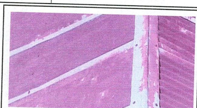
Foto 8: sustitución de elementos de fijación
