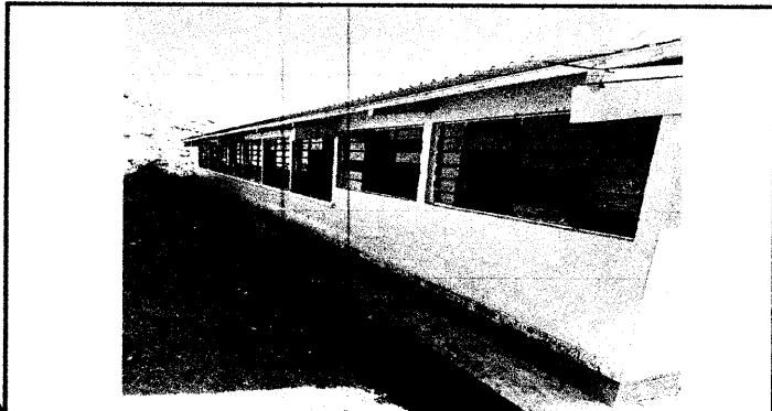
Foto 1: Ventanas en mal estado
