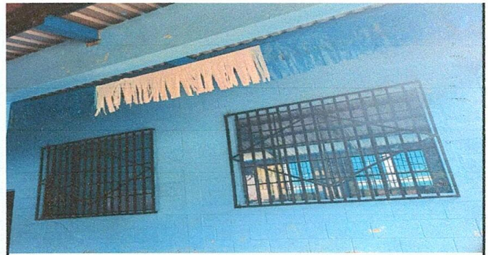
Foto 6: Finalización de balcones
