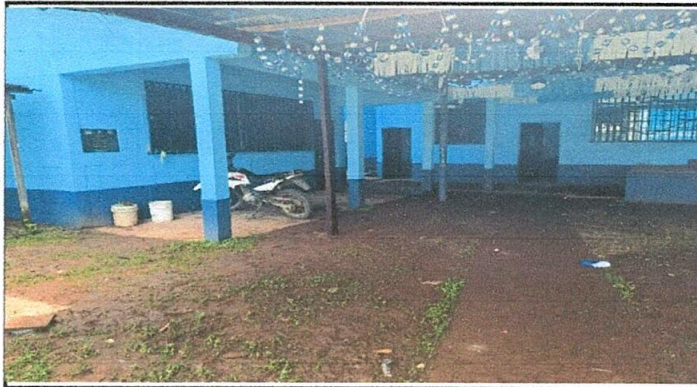
Foto 7: Finalización de Pintura en Paredes Exteriores
