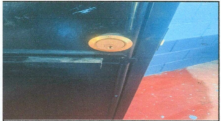
Foto 2: Finalización de pintado de puerta
