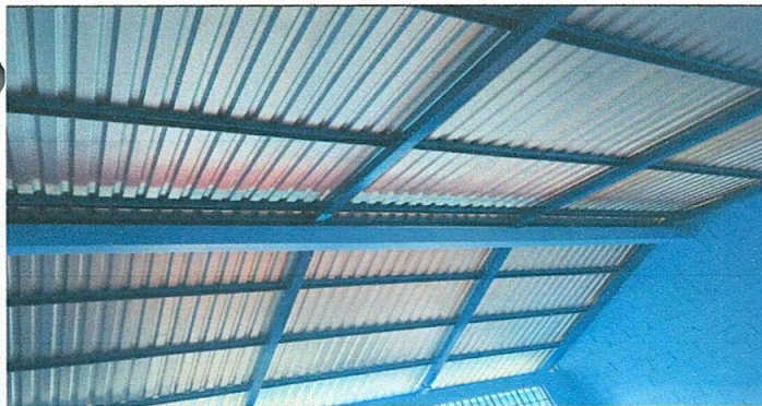
Foto 5: Finalización de techo parte inferior
