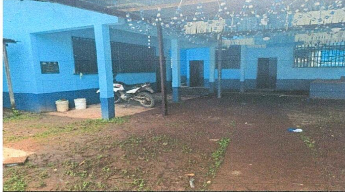
Foto 1: Finalización pintura completa en el centro Educativo
