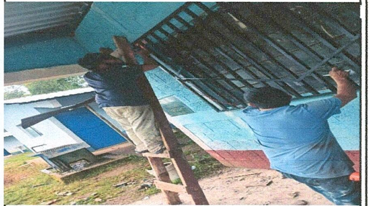
Foto 6: Sustitución de balcones
