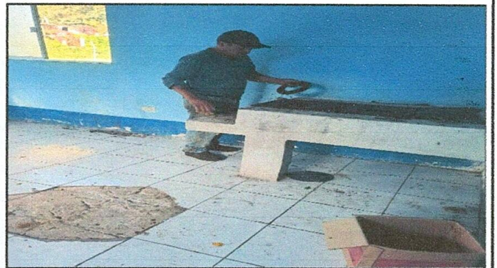
Foto 4: Sustitución de plancha de metal y chimenea de metal por tubo de concreto
