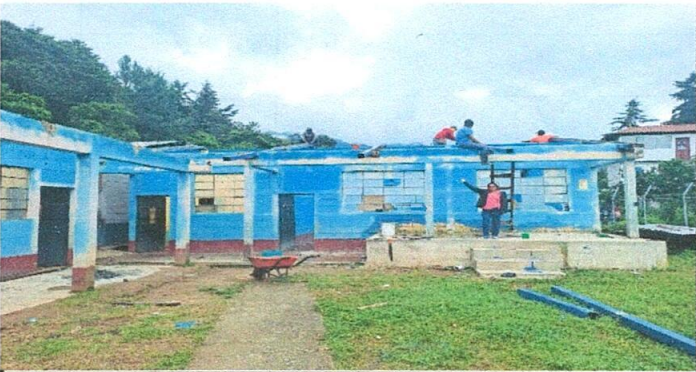
Foto 5: Sustitución de lamina por lamina maxalum C26
