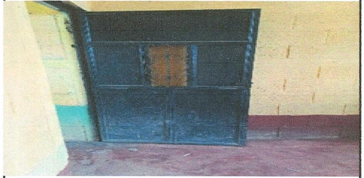
Foto 2: Reparacion de puerta de metal, por puerta de metal
