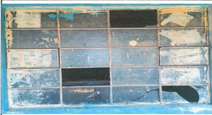
Foto 3: Sustitución de vidrios por vidrios
