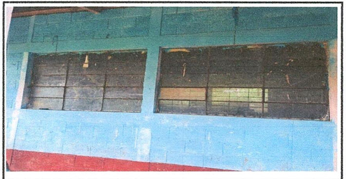
Foto 6: Sustitución de balcones
