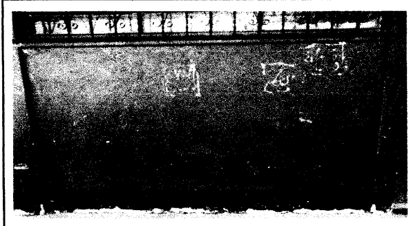
"Foto 4: PINTURA EN MUROS EXTERIORES E INTERIORES del aula y dirección en mal estado la pintura
