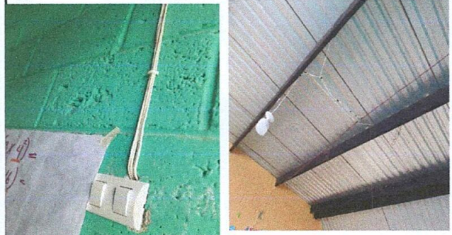
Foto 2: Reparación de sistema eléctrico
