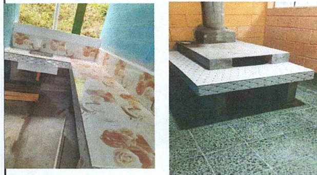
Foto 3: Reparación de cocina
