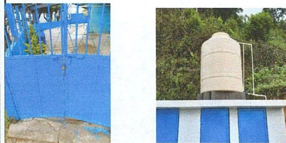
Foto 5: Reparación de porton principal y cambio de deposito de agua
