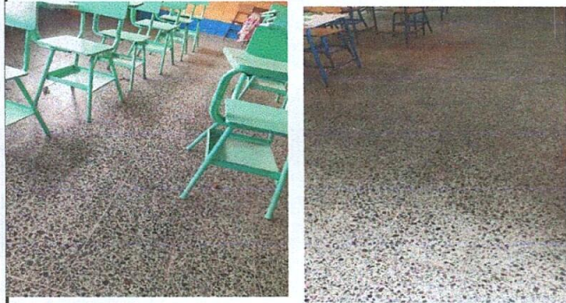
Foto1: Cambio de piso
