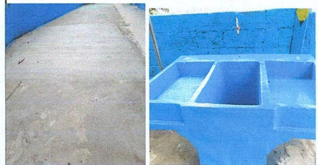
Foto 6: reparacion de piso de concreto y sustitución de de pila
