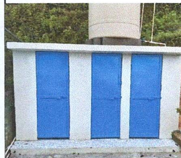
Foto 4: Mejoramiento de servicios sanitarios y depósito de agua
