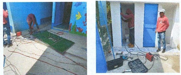
Foto 6: Insalación de puertas de sanitario y reparación de puertas de modulos
