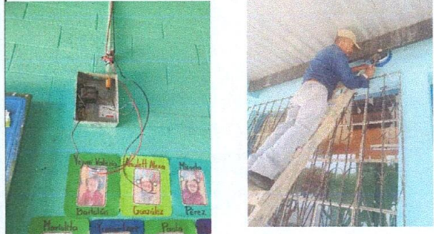
Foto 2: Reparación de sistema eléctrico
