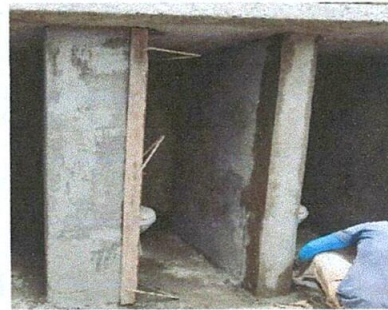
Foto 4: Mejoramiento de servicios sanitarios
