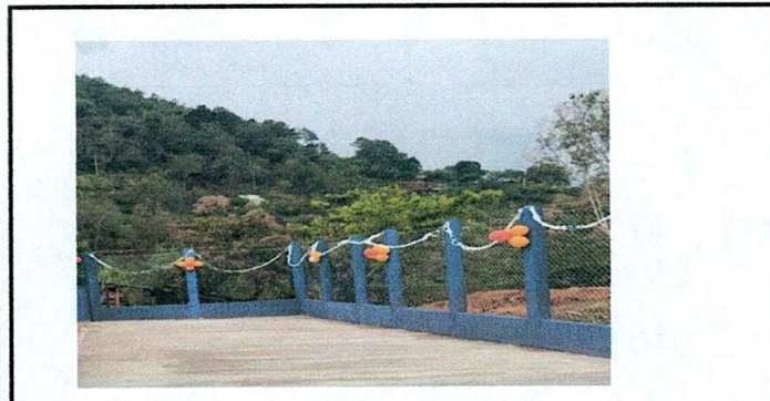
Foto 5: Reparacion de muro de contencion
