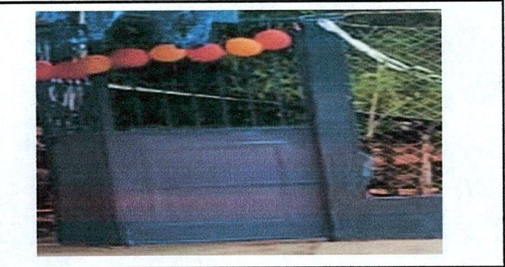
Foto 4: Sustitucion de portones
