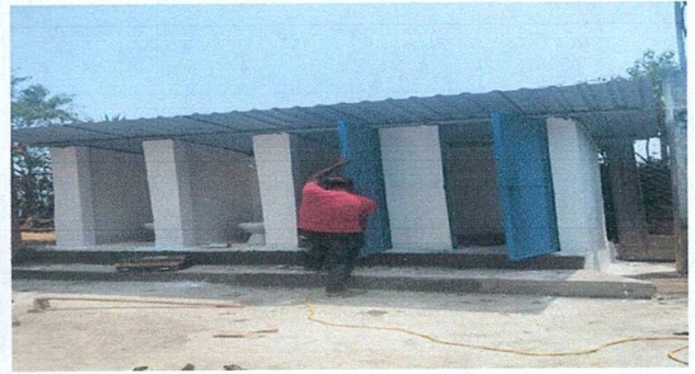
Foto 2: Remodelacion de inodoro
