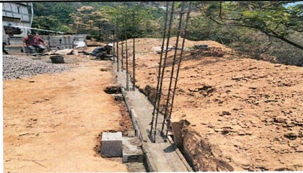
Foto 5: Reparación de muro de contencion
