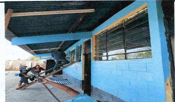
Foto 6: Sustitucion de Ventanas
