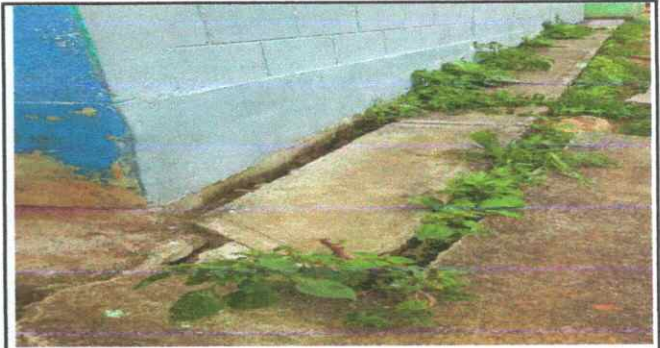
Foto 2: Sussttución de banqueta de concreto
