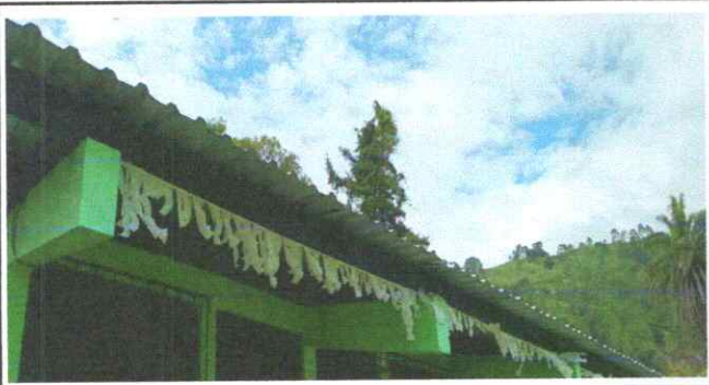
Foto 1: Mejoramiento de bajada de agua pluvial
