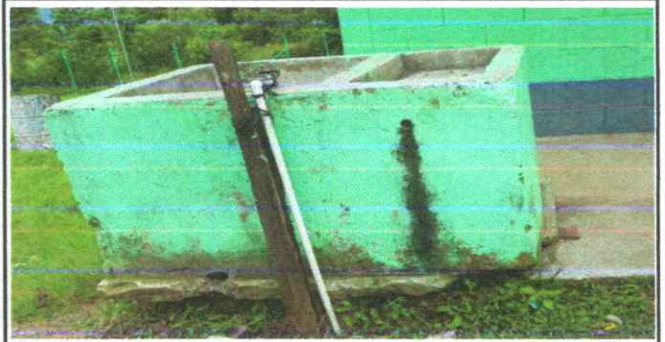
Foto 2: Sustitución de pila de concreto
