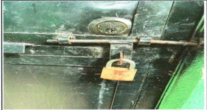
Foto 2: Sustitución de chapas
