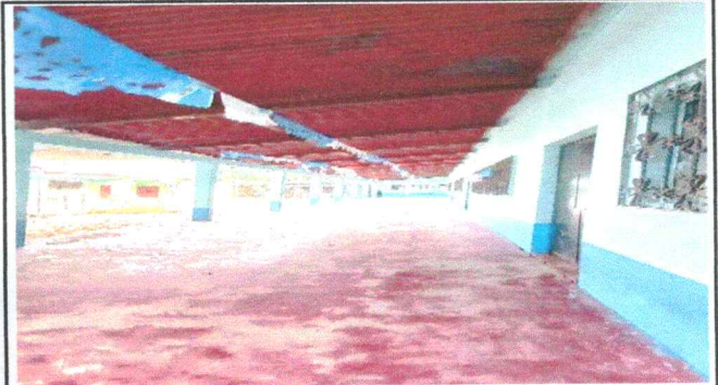
Foto 2: SUSTITUCION DE CAMBIO DE MADERA POR METAL
