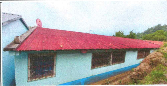
Foto1: CAMBIO DE TECHO DE LAMINA
