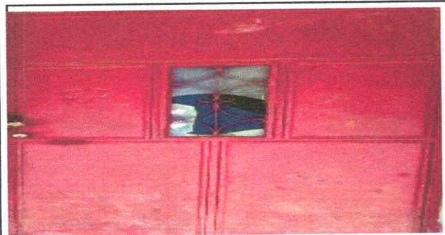
FOTO5: MEJORAMIENTO DE PUERTA
