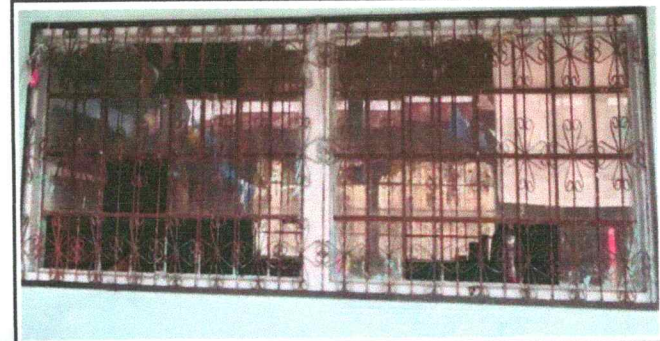
Foto 6: MEJORAMIENTO DE VENTANAS
