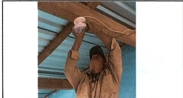
Foto 4: Cambio de instalacion Electrica
