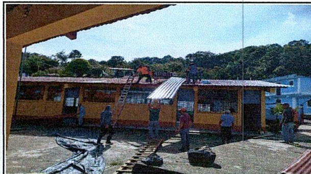
Foto 3. Cambio de lámina por lamina troquelada
