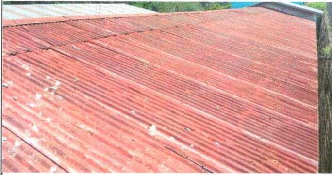
Foto1: SUSTITUCIÓN DE LÁMINA,M POR LÁMINA TROQUELADA TR-101 CAL 26 ZINTROALUM
